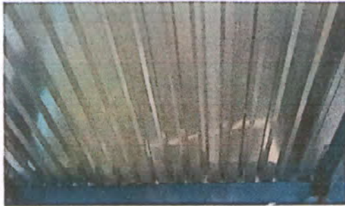
Foto1: Sustitución de lámina troquelada aluzinc calibre 26 en área de la pila
