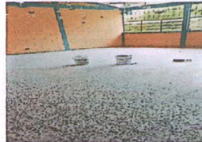
Foto 2: Sustitución de piso de cemento liquido por piso de grantio en el aula de Tecero y Cuarto Grado
