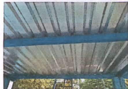
Foto 4: Sustitución de estructura de soporte de madera por metal en el área de la pila
